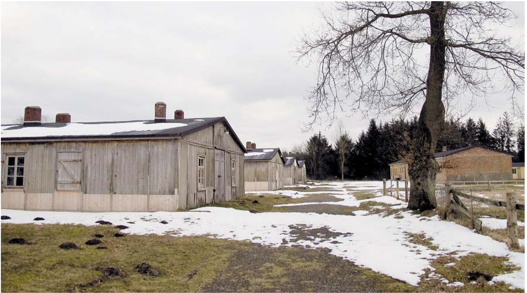
Erst Lager für den freiwilligen Arbeitsdienst, dann für Kriegsgefangene – und heute zum Teil Stauraum: Baracken des Lagers „Sandbostel“ bei Bremervörde Foto: Knut Henkel
