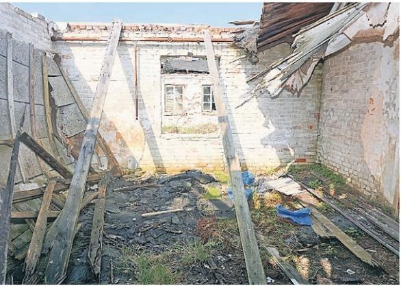
So oder noch schlimmer sehen die einzelnen Bereiche der verfallenen Baracken aus. Große Teile der Decke sind eingestürzt und verrottet auf dem Boden.
