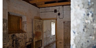
Blick in eines der noch erhaltenen Gebäude auf dem ehemaligen Lagergelände.
