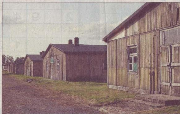
Die Dächer von sieben Baracken sind im Zuge des ersten Bauabschnitts zur Gebäudesicherung erneuert worden. Foto: bz/ts
