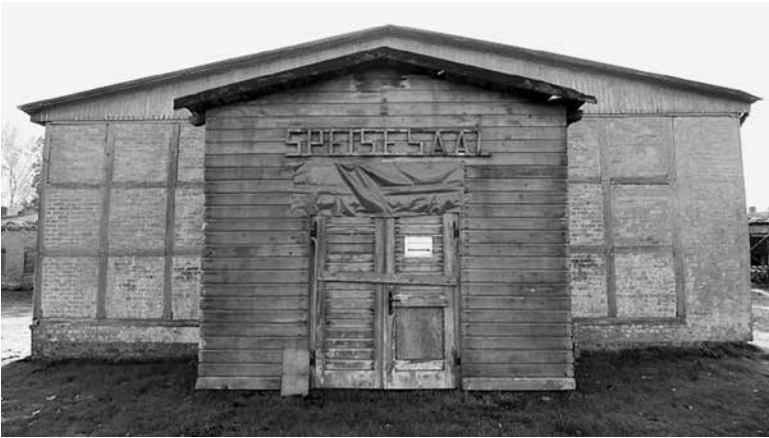
Abb. 2: Ansicht eines 1940/41 zusätzlich errichteten Anbaus an die Lagerküche A. Der kleine hölzerne Vorbau mit dem Schriftzug »SPEISESAAL« und einem dahinter befindlichen großen Durchbruch in die historisch geschlossene Giebfassade stammt aus der Zeit des Notaufnahmelagers für jugendliche Flüchtlinge aus der DDR. Ebenfalls in den 1950er-Jahren wurde die rechte Fachwerk-Außenwand des Anbaus aufgrund von Baufälligkeit durch massives Mauerwerk ersetzt. Foto: Andreas Ehresmann, 19. 4. 2008.
