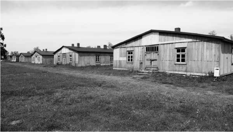
Abb. 4: Ansicht der historischen Unterakunftsbaracken nach der Fassadenanierung. Erkennbar sind die ausgewechselten Fassadenteile. Vor allem die Fußpunkte der Außenwände auf der Wetterseite mussten in weiten Teilen erneuert werden. Foto: Andreas Ehresmann, 21.5.2012.
