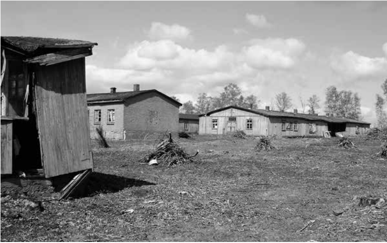
Abb. 1: Blick über einen Teilbereich des Gedenkstätten Geländes vor Beginn der Sanierungsmaßnahmen. Foto: Andreas Ehresmann, 18. 4. 2007.
